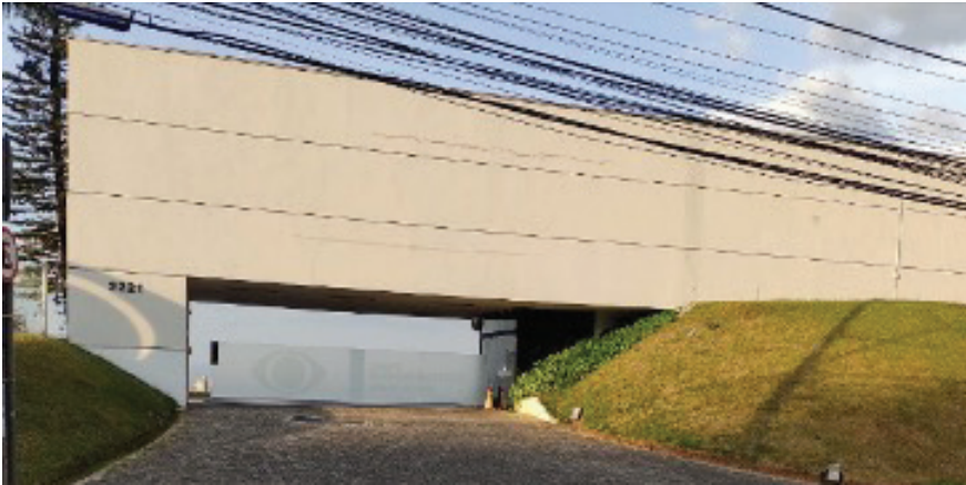
Figura 3 – Sede da TV Bandeirantes, com abertura vedada, que impede a visão. Fonte: autores.
